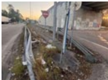
vía A-55 e na estrada N-550.
