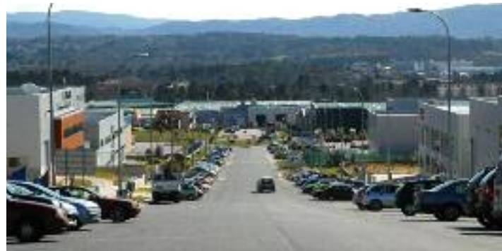
Vista parcial do parque empresarial do Pereiro de Aguiar.
