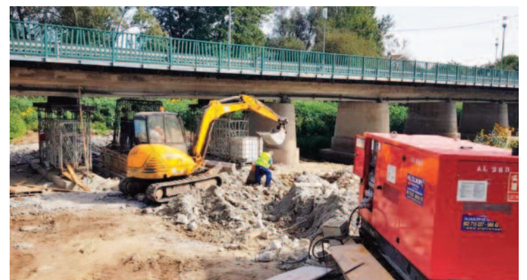
Desvíase o río Cabe a través dos vanos da marxe esquerda.
