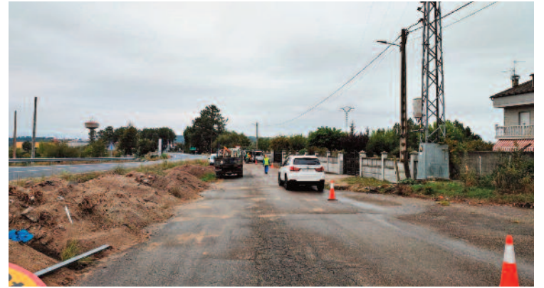
A Xunta está a executar 16 qms. de itinerarios cun orzamento de 7,1 M€.
