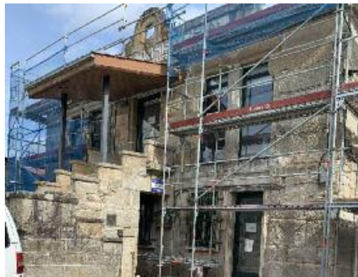
Estado actual das obras na biblioteca municipal.
