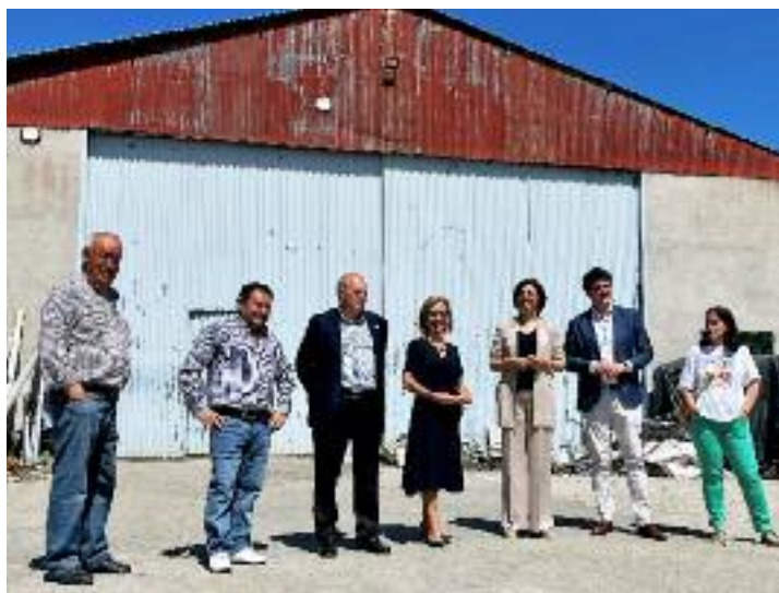
En Pantón a mellora afectará a esta nave municipal.
