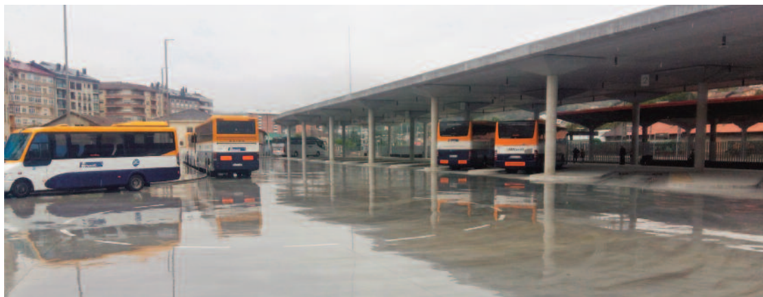
Estación de autobuses de Ourense.
