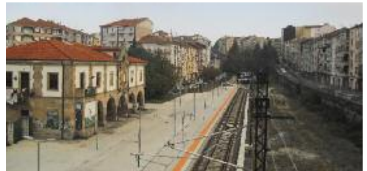
Antiga estación do tren no barrio de San Francisco.
