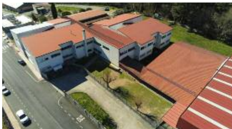
O proxecto contempla o cambio de carpinterías, luminarias e radiadores.
