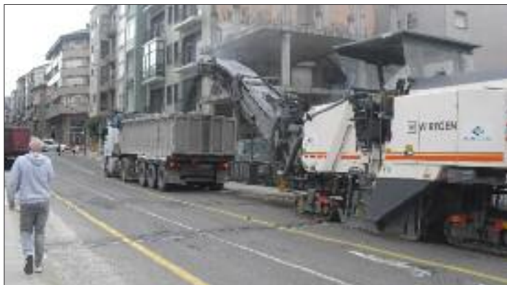
As obras na ponte sobre os ríos Barbaña e Barbañica.
