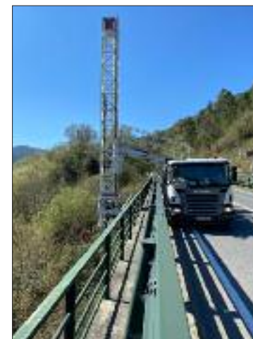
Labores de inspección das pontes.
