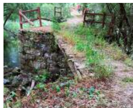
Ponte de Soutelo.
