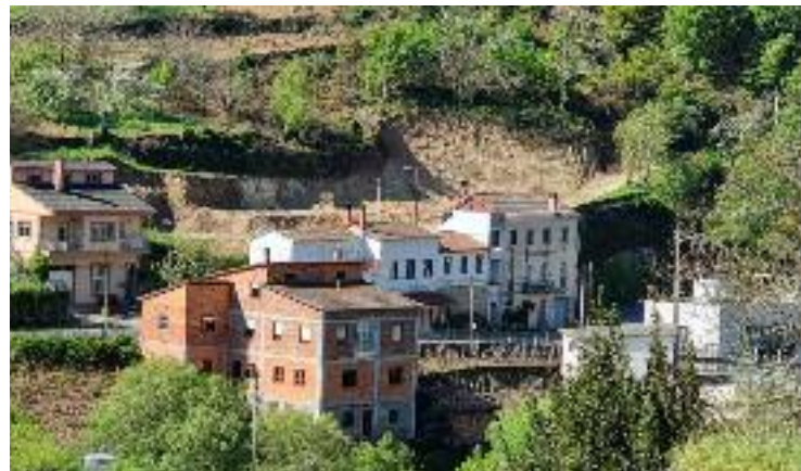
Nos Peares só está feita a escavación para a residencia.
