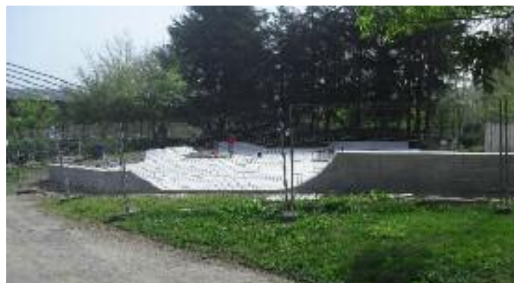
“Skate park” en construción no Parque do Couto.
