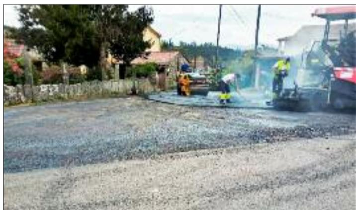
As obras consisten na mellora da pavimentación de dous camiños municipais que se atopan actualmente nun avanzado estado de deterioro, polo que se fará una renovación completa da capa de rodadura. Para a pavimentación definitiva estenderase e compactarase unha capa de rodadura de mestura bituminosa en quente tipo AC 16 Surf 50/70 D.
