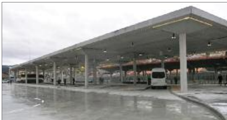
Continuarán os traballos do aparcadoiro subterráneo e de integración na contorna.
