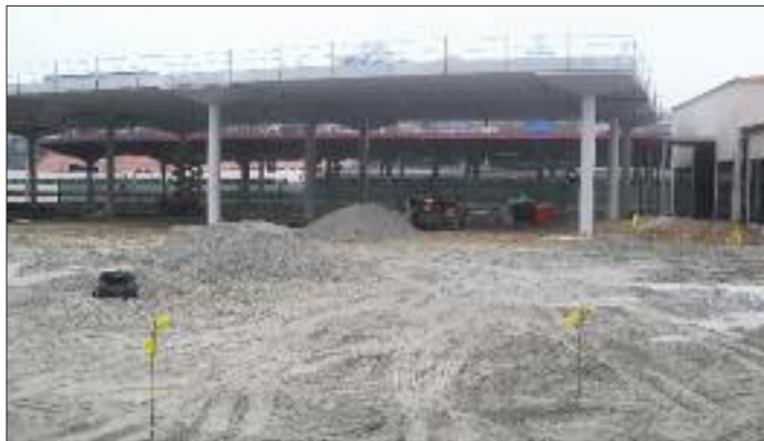
Estado actual das obras da terminal a carón da estación do tren.
