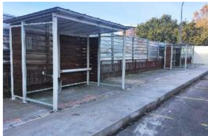
A actual estación de buses está demoléndose.
