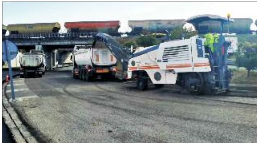
Obras realizadas nas estradas dos polígonos.
