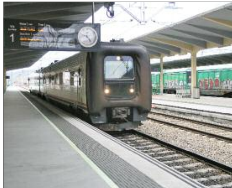
Estación ferroviaria de Monforte de Lemos.
