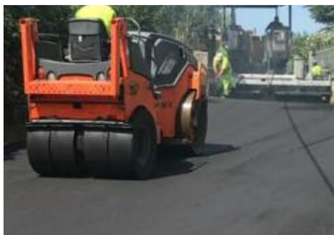
Obras en vías de titularidade municipal.
