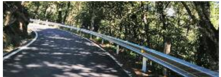
Os biondas substituíron ás pedras protectoras.
