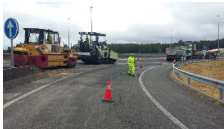
Obras de renovación do firme na autoestrada AG-53.
