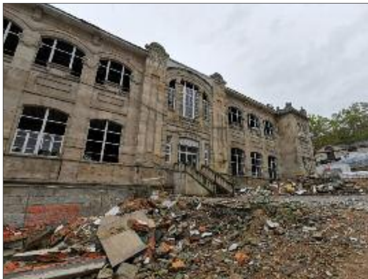
Estado actual das obras na Praza de Abastos.
