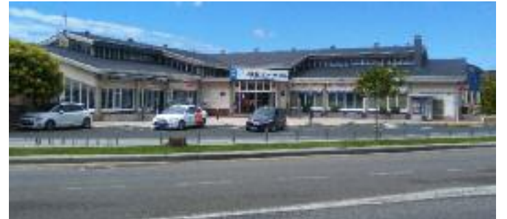
O proxecto incluíu a substitución total da cuberta e outras melloras na dársena e no interior.
