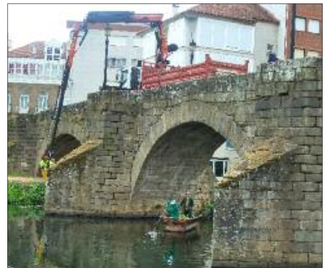
Traballos de limpeza na Ponte Vella.
