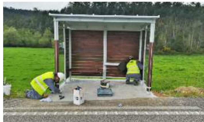
A marquesiña xa está en servizo na estrada LU-152.
