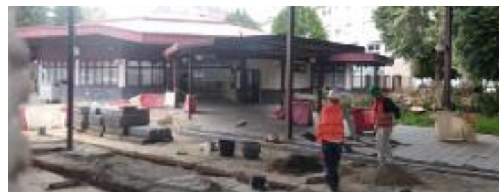
Obras na estación de buses.
