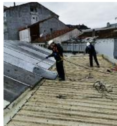
Operarios traballando no tellado da estación.
