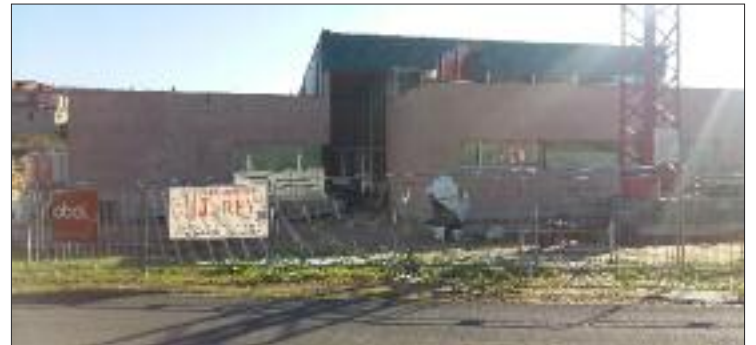
O novo centro de saúde está en obras.
