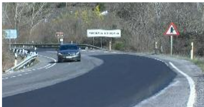
Obras de mellora na estrada nacional 120.
