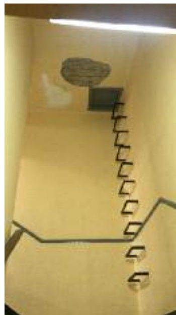
Desprendementos de escaiola no edificio nobre de Praza Maior.
