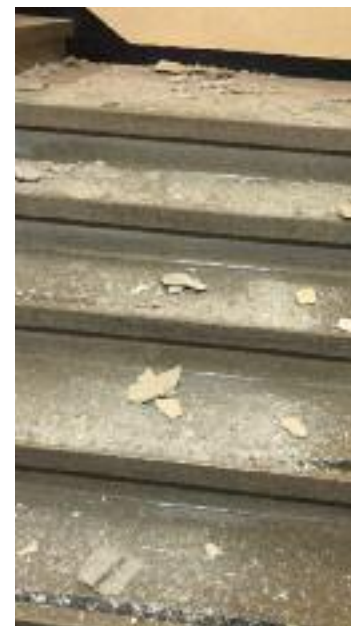
Desprendementos de escaiola no edificio nobre de Praza Maior.
