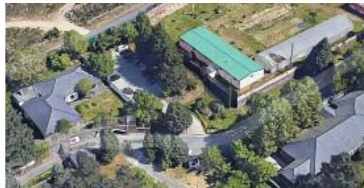
Instalacións do Centro de Menores Monteledo, de Ourense.
