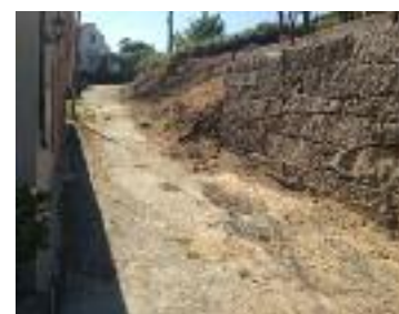
Comezo da obra na Ladeira
