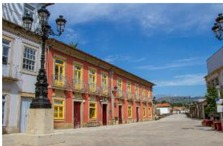
Albergue de Peregrinos Ponte de Lima
