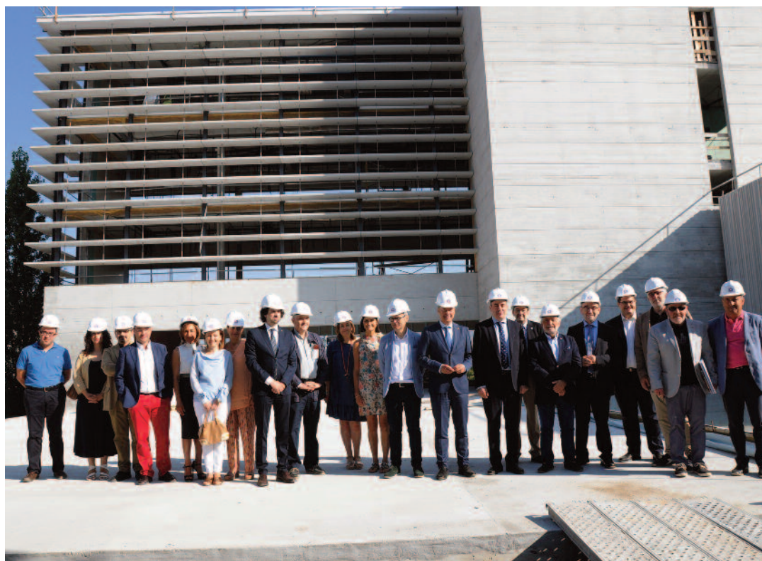
Visita ás obras do novo edificio no que a Xunta mobilizou 4,4 millóns de euros.
