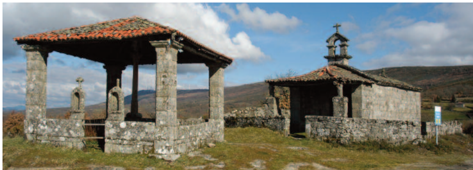
Conxunto relixioso de Marrubio (Montederramo) con cruceiro de madeira policromado, dous petos de ánimas e capela de san Antonio.
