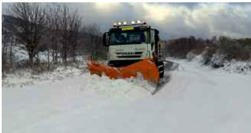
A Deputación de Lugo acondicionou estradas na montaña por acumulacións de neve.
