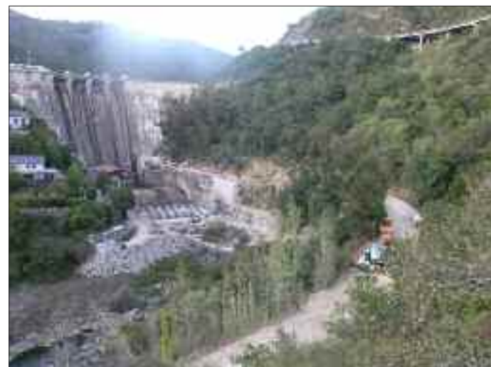
Presa de santo Estevo, en Nogueira de Ramuín. (Ourense).
