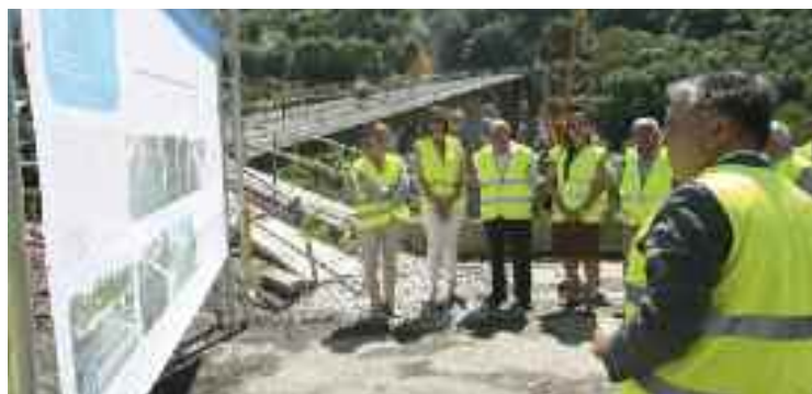
■ A ponte entrará en servizo neste outono.
