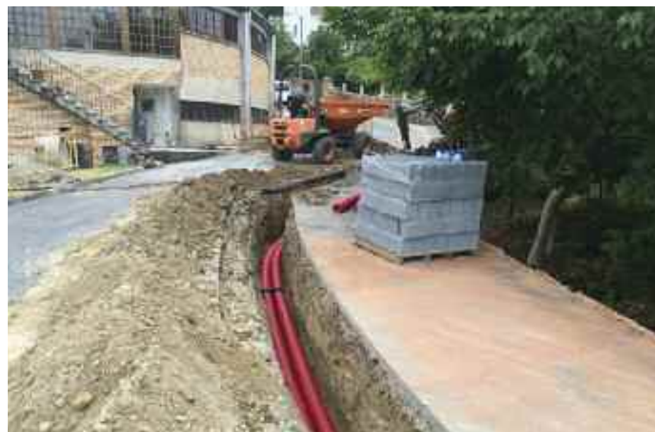
■ Estado actual das obras na rúa da Igrexa.
