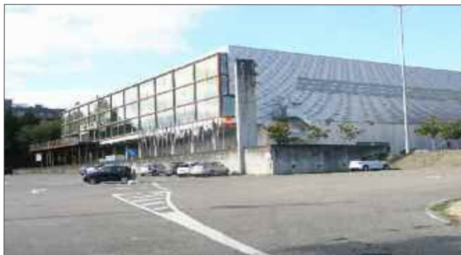
■ Instalacións da Fundación Feiras e Exposicións de Ourense.
