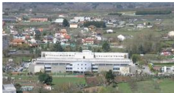
Hospital comarcal de Monforte.
