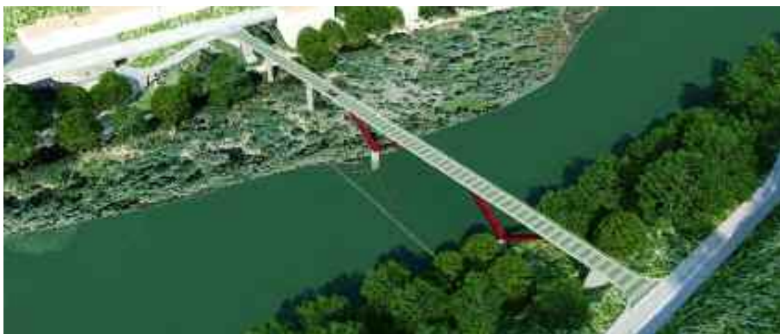
■ A infraestrutura terá 202 metros de lonxitude, calzada de 3,25 metros e beirarrúa de 1,25 metros
