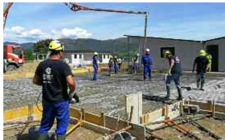
O edificio terá douscentos metros cadrados.
