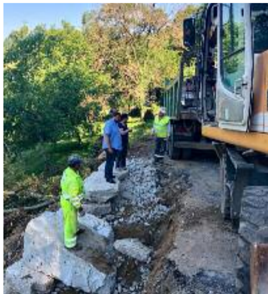
Construción dun muro de contención.
