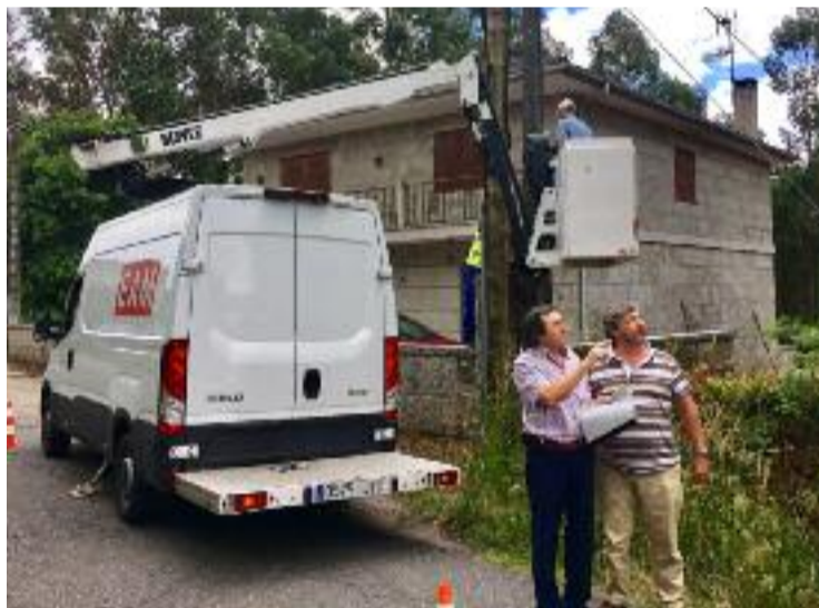
Jose Antonio Fernández, Xerente de Electra Alto Miño, e Miguel González, Concelleiro de Vías e Obras, supervisando a obra de instalación de fibra óptica
