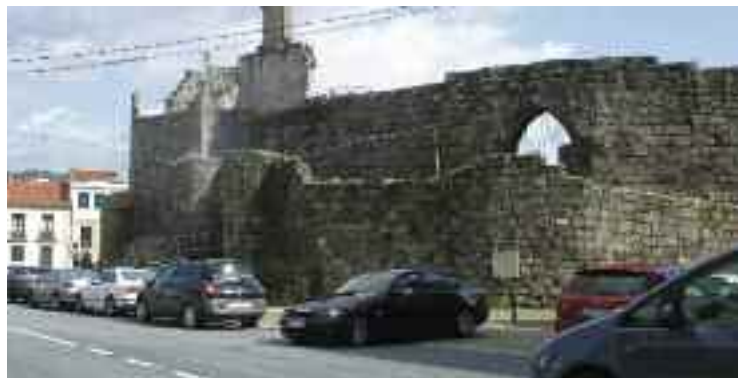
■ Exterior do castelo con “elementos estéticos discordantes”.
